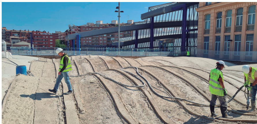
Nouvelle gare routière de Lleida. Constructeur : CA(OH)2 + Romero Polo + Copisa.
