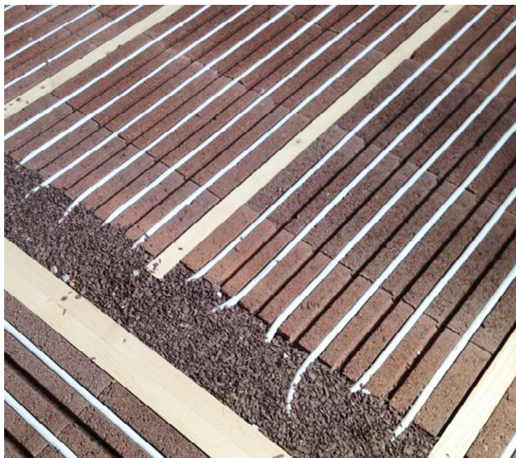
La combinaison parfaite : les spirales chauffantes et les plaques moulées de Lithotherm alliées à l'isolant en vrac CW 2000 de
