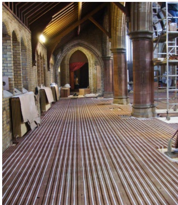
Un projet de grande envergure : rénovation du revêtement de sol dans une église à Londres
