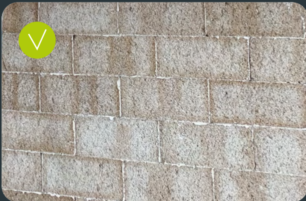
Bon traitement des joints
